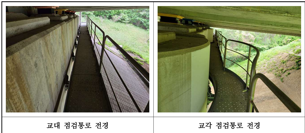
【사진 43.3.26】 교량 점검시설 전경
