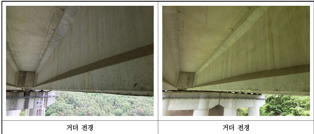
【사진 43.3.4】 거더 전경
