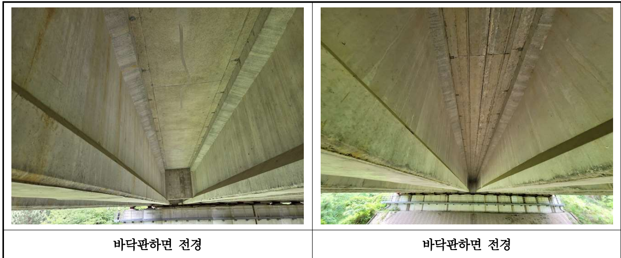
【사진 43.3.2】 바닥판하면 전경
