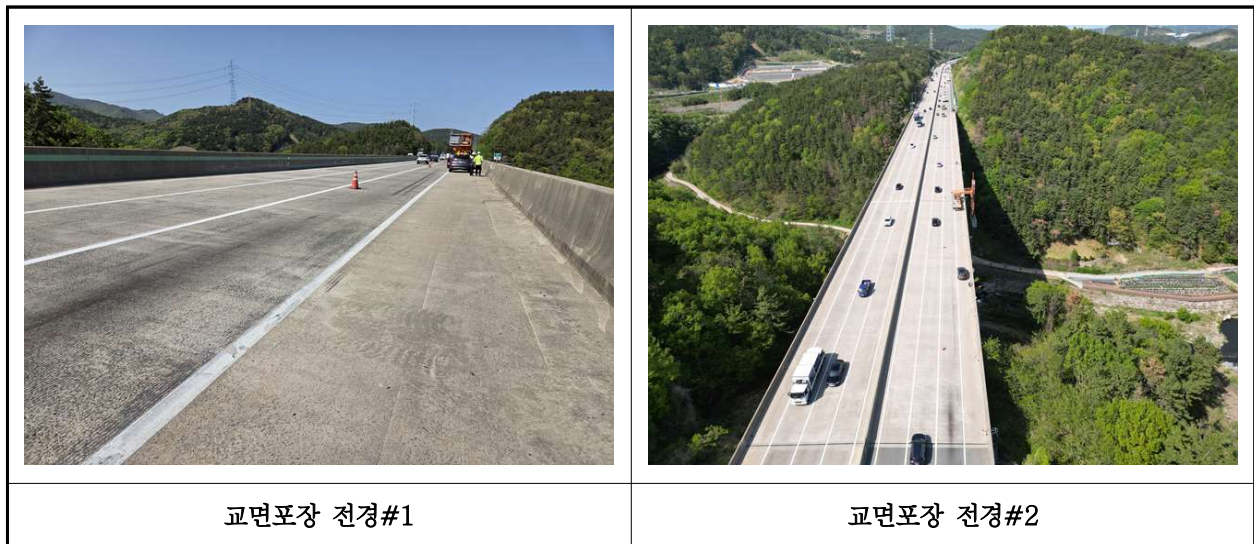
【사진 43.3.20】 교면포장 전경
