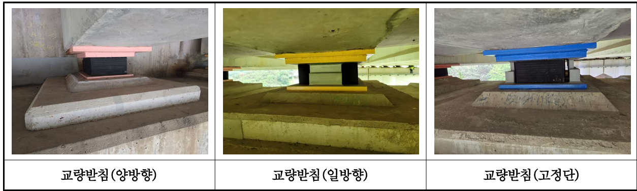
【사진 43.3.13】 교량받침 전경
