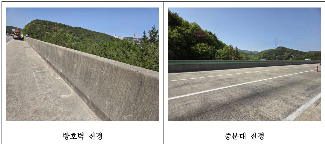
【사진 43.3.24】 방호벽 및 중분대 전경
