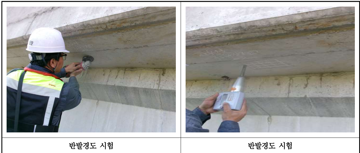
【사진 43.4.2】 반발경도시험 현장사진
