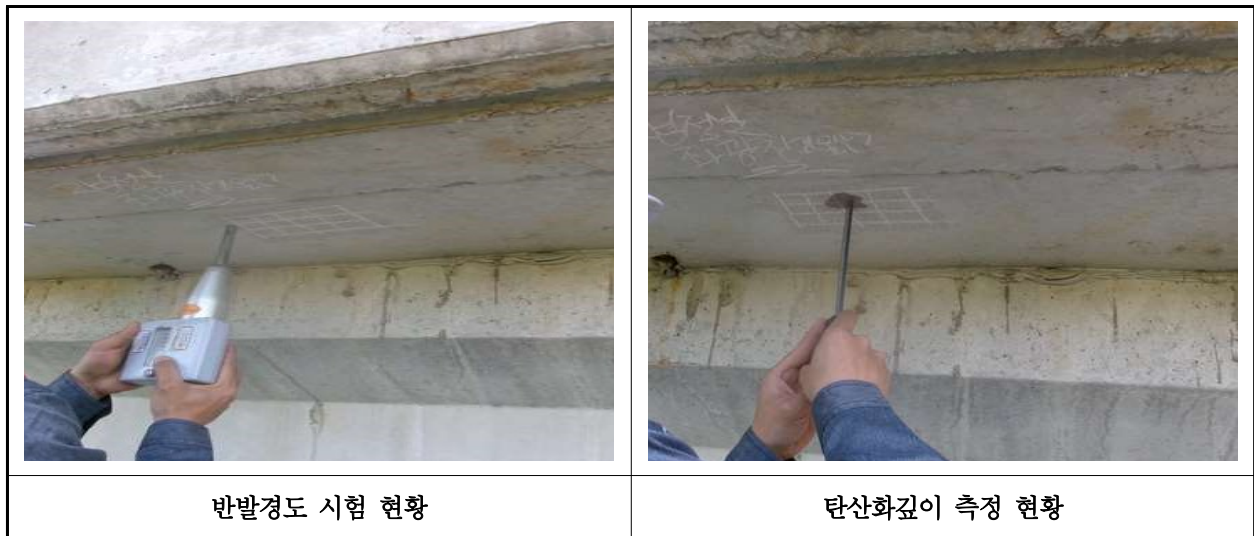
【사진 43.4.1】 콘크리트 내구성조사 현황
