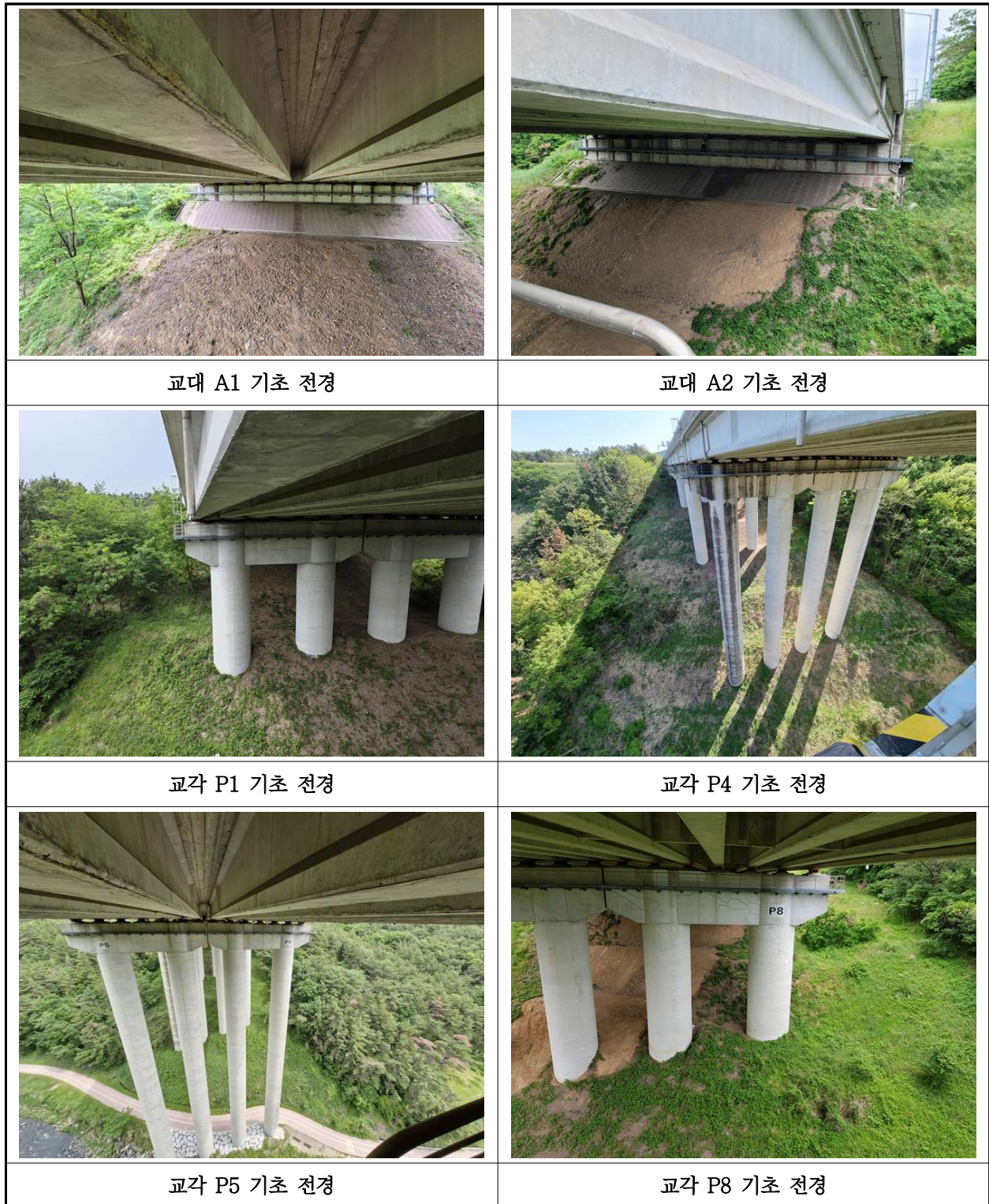
【사진 43.3.12】 기초 전경
